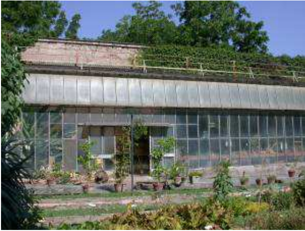
La vecchia serra durante i lavori di smantellamento (2005)
